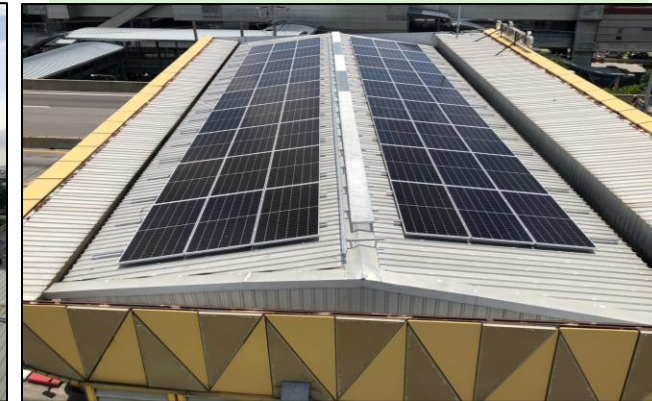
ติดตั้ง Solar Rooftop ด่านเก็บค่าผ่านทาง
